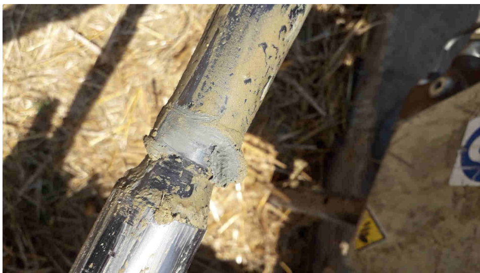
Postazione di Prova Cpt4
