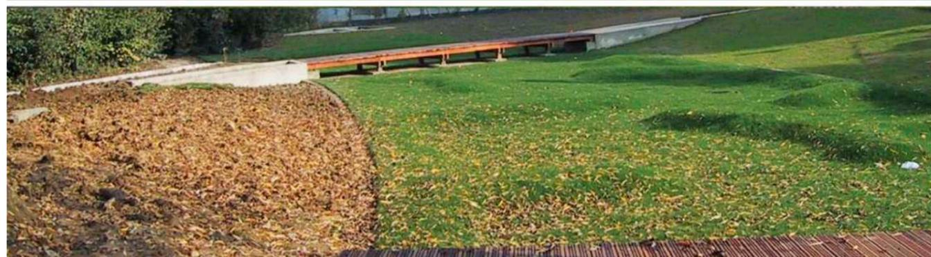
Sono opere per lo stoccaggio, la decantazione e/o l'infiltrazione delle acque meteoriche. Sono spazi vegetati poco profondi, diversi per dimensione e configurazione :
