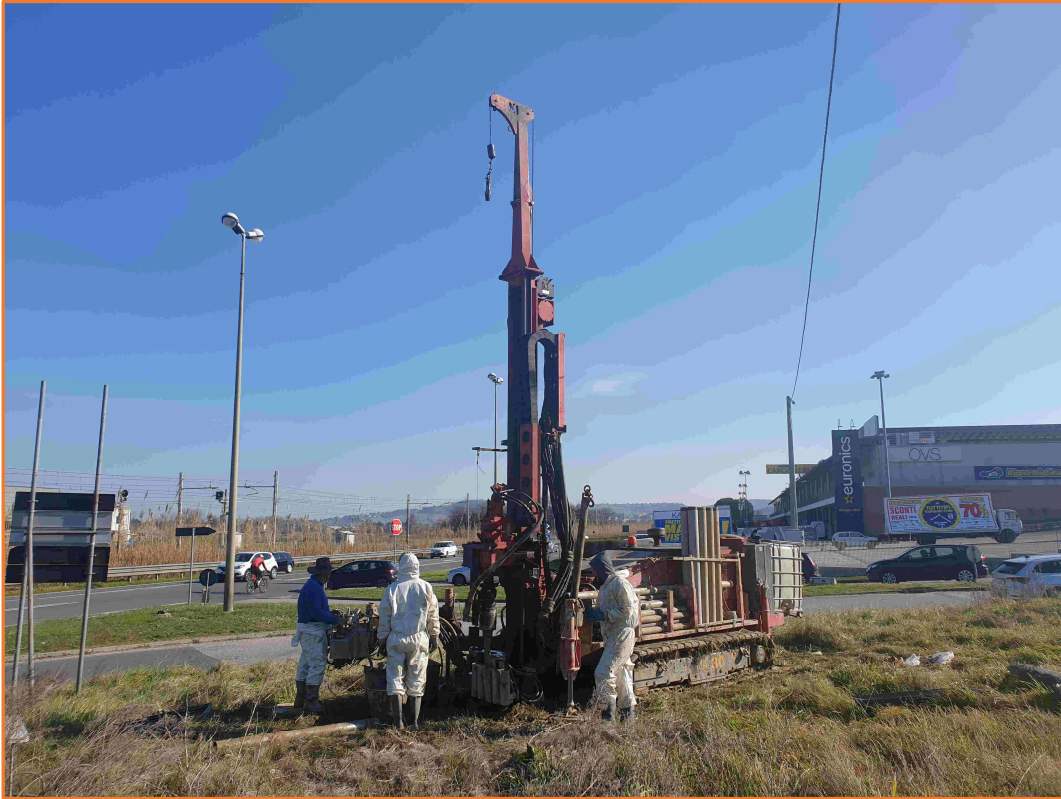
Postazione trivella SONDAGGIO S1
