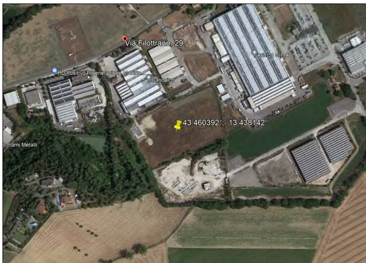
Foto 1: ubicazione sito oggetto di studio
