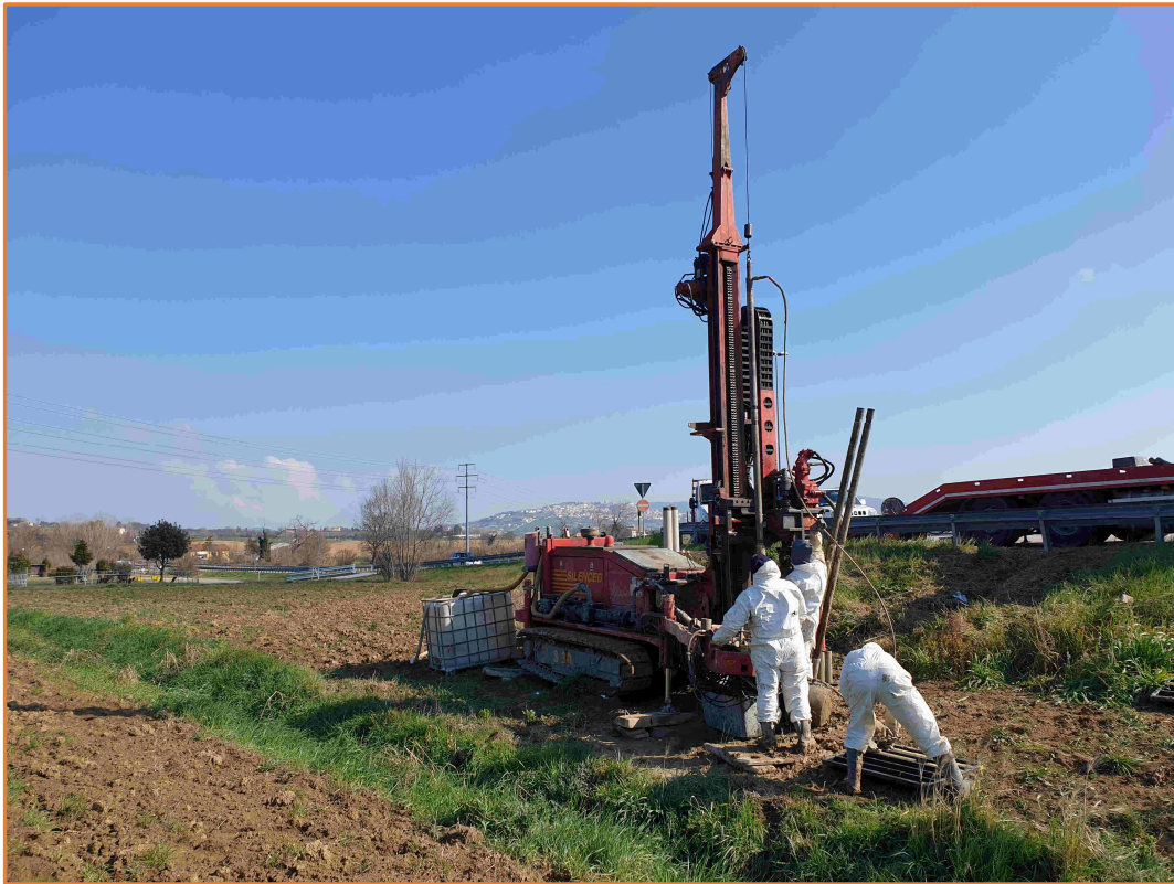
Postazione trivella SONDAGGIO S1
