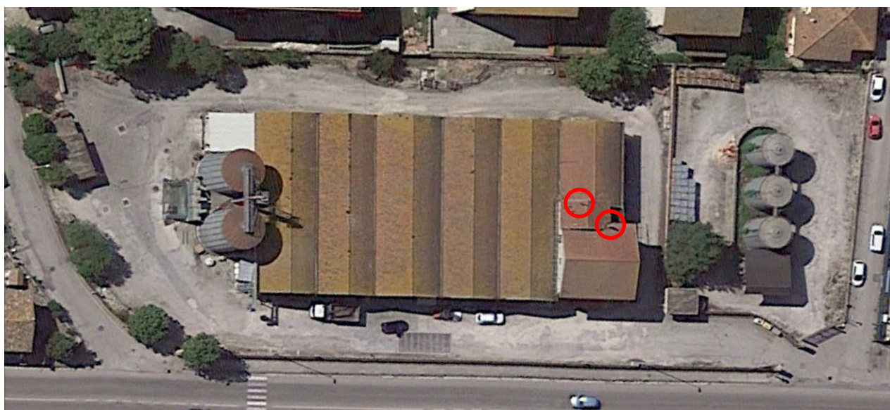
Figura 1 - Individuazione canne fumarie: unici manufatti rimasti contenenti amianto
