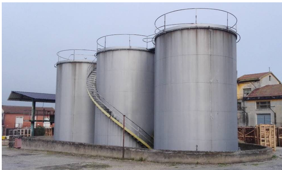
Figura 5 - Serbatoi fuori terra entro bacino di contenimento
