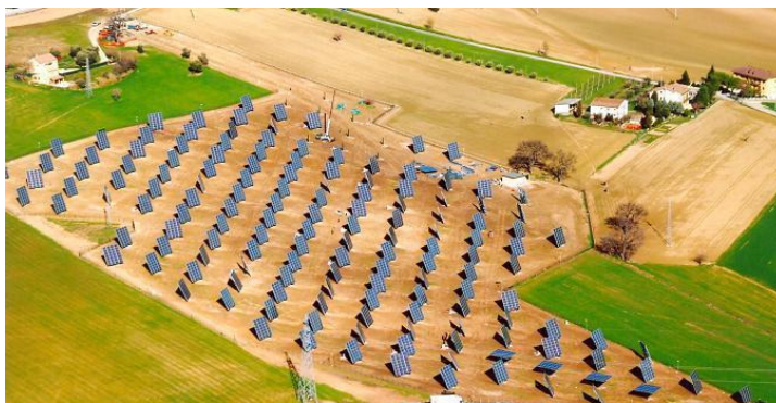
Fig. 4.1 – Impianto fotovoltaico di via Giuggioli, località S. Sabino di Osimo
